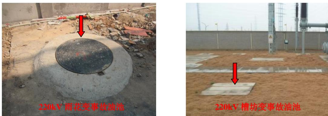
图 6-2 各 220kV 变电站事故油池
