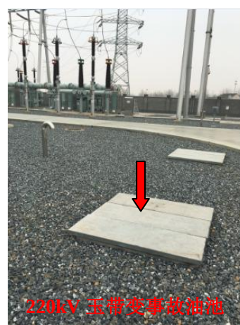
图 6-2 各 220kV 变电站事故油池
