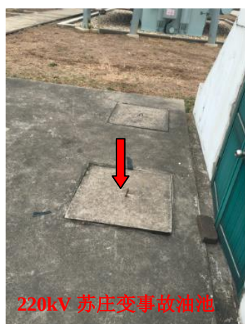
图 6-2 各 220kV 变电站事故油池
