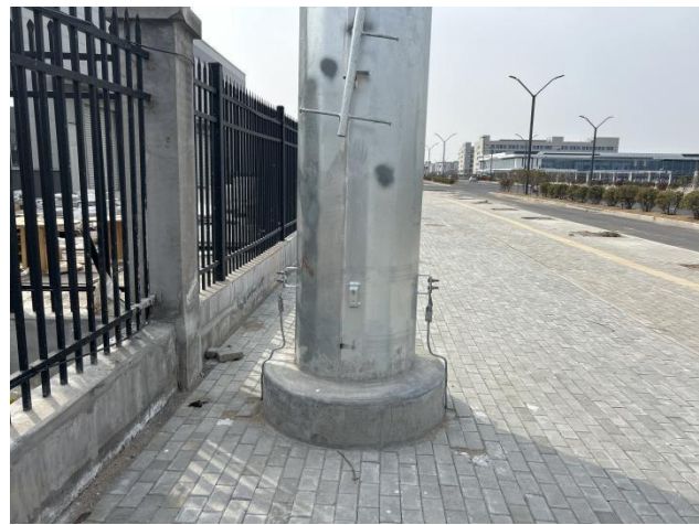
110kV 蒋睿 8L81 线 2#/梁蒋 8A50 线睿晶支线 3#杆塔周围硬化示例
