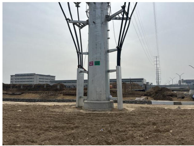
110kV 蒋睿 8L81 线 1#/梁蒋 8A50 线睿晶支线 2#杆塔周围复耕示例
