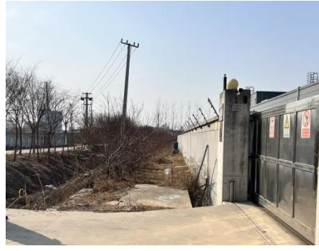
110kV变电站南侧
