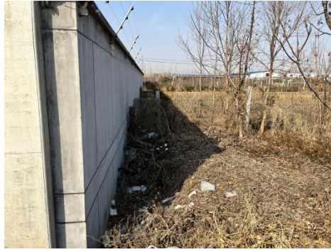
110kV变电站东侧
