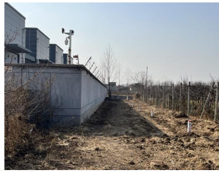
110kV变电站北侧
